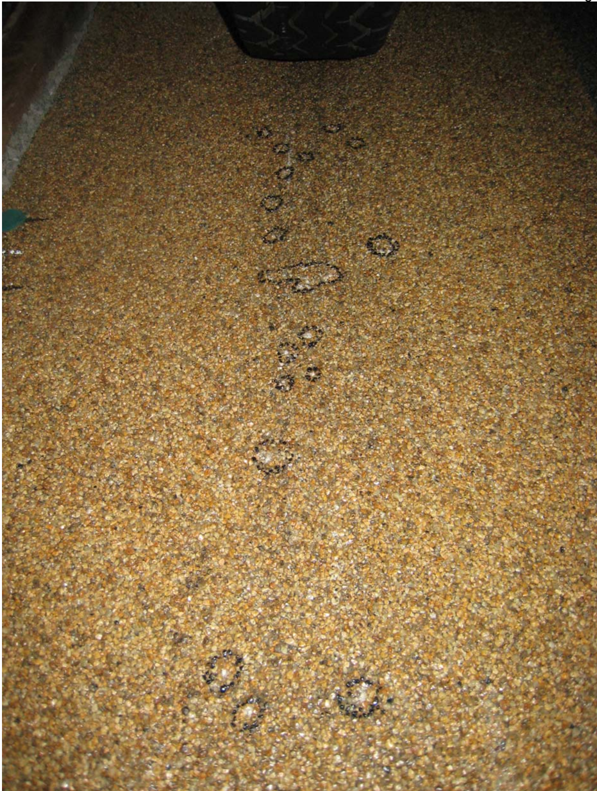
Bild 3: Zustand der Deckschicht 2/4mm nach 2.000 LW in Phase 6 mit zusätzlicher Bremskrafteinleitung (insgesamt: 47.000 LW). Zur Verdeutlichung sind die Ausbruchbereiche schwarz eingekreist.
