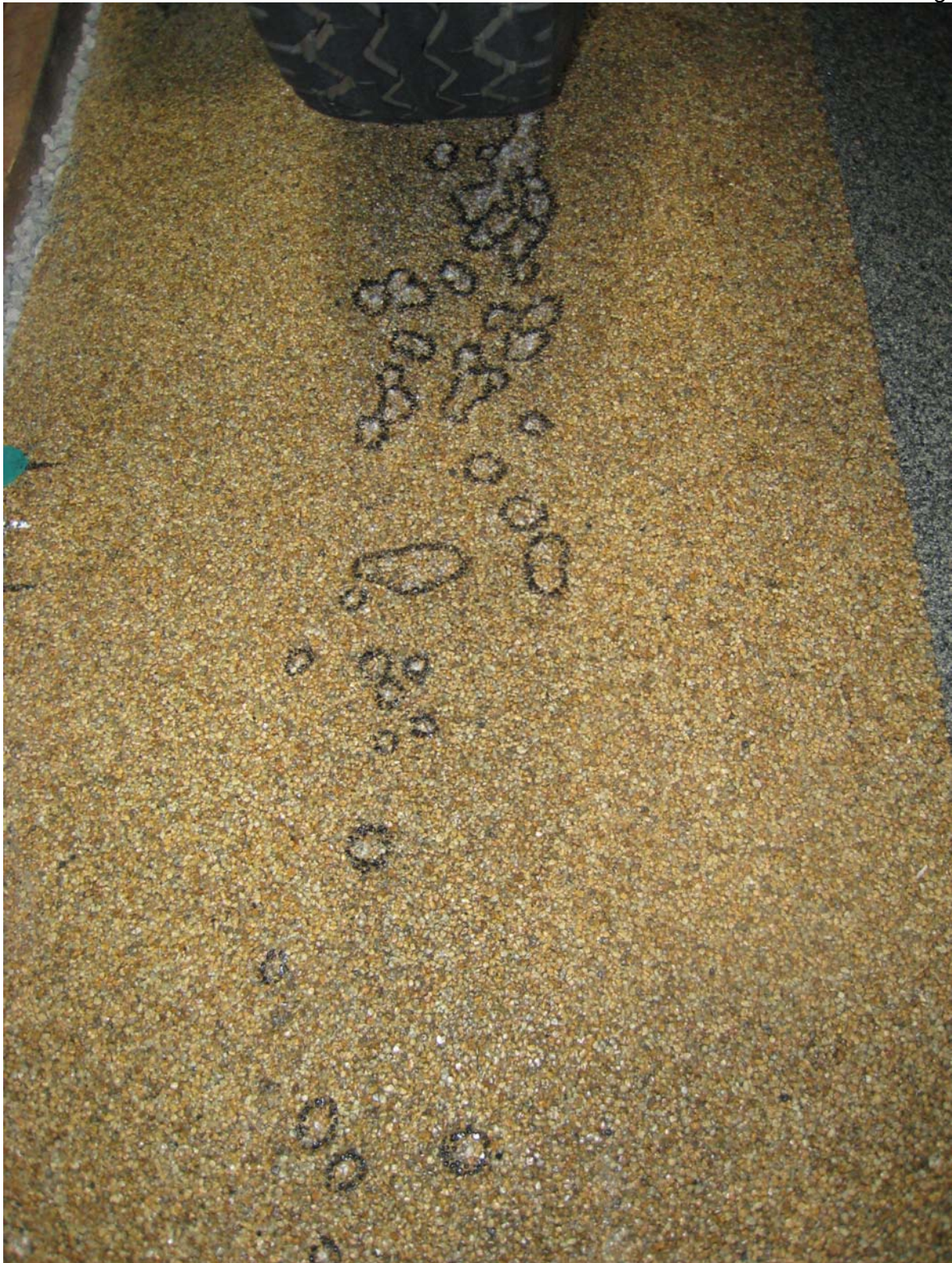
Bild 4: Zustand der Deckschicht 2/4mm nach Abschluss der Phase 6 mit zusätzlicher Bremskrafteinleitung (insgesamt: 50.000 LW). Deutliche Zunahme der Ausbrüche gegenüber dem Zustand in Bild 3.
